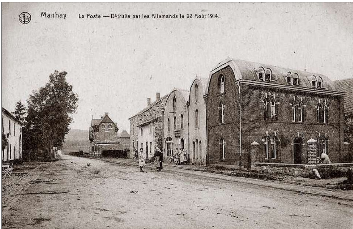
La Poste est le 3 e bâtiment en partant de la droite. A l'arrière de la photo à droite, la gare du Vicinal qui existe toujours et abrite aujourd'hui la bibliothèque, une halte garderie et des salles de réunion et d'exposition.
