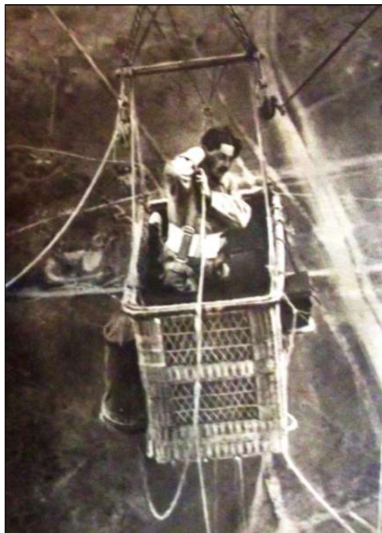
Un poste d'observation situé dans une nacelle avec liaison téléphonique. La photo a été prise depuis une autre nacelle. 116
