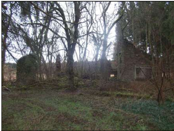
Ruines du chalet Gilkinet. (Parking à la sortie de Manhay vers Bastogne, à 100m dans le chemin à droite.)
