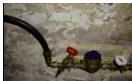
Installation en socarex
